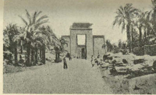
Fig. XXXVI (a) — Vista da avenida oriental das sphinges (à direita) tendo ao fundo a porta de Philadelpho e o pylone do templo de Mut (Karnak)
